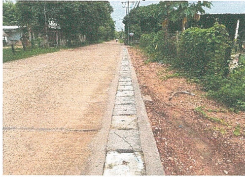
โครงการก่อสร้างร่องระบายน้ำ หมู่ที่ ๑๔ ทางเข้าวัดป่าจิตตساโร
