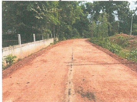
โครงการก่อสร้างถนน คสล. หมู่ที่ ๙ ถนนเศรษฐกิจ
