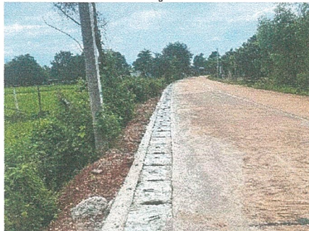
โครงการก่อสร้างร่องระบายน้ำ หมู่ที่ ๘ ถนนทางเข้าบ้านนาหลวง
