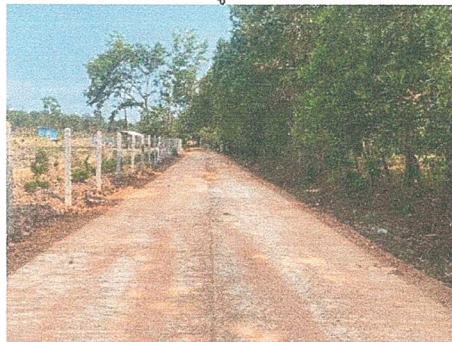
โครงการก่อสร้างถนน คสล. หมู่ที่ ๗
