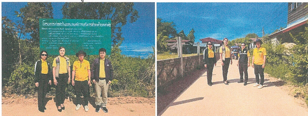
โครงการก่อสร้างถนน คสล.หมู่ที่ ๔
