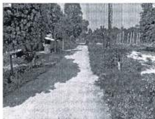
กม. ๐ + ๕๕๐ (สภาพสายทางโดยทั่วไป)
