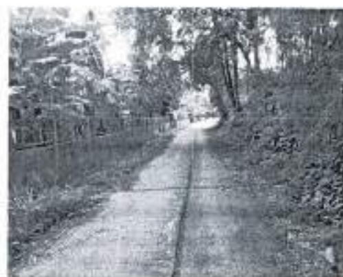
กม. ๐+๘๐ (สภาพสายทางโดยทั่วไป)
