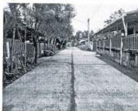
กม. ๐+๑๕๗ (สภาพสายทางโดยทั่วไป)
