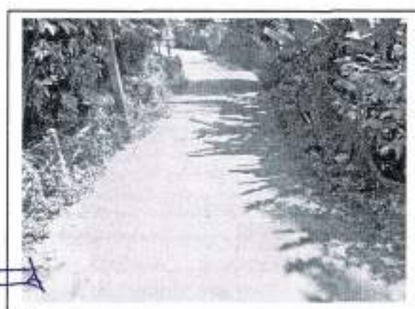
กม. ๐+๑๐๗ (สภาพสายทางโดยทั่วไป)
