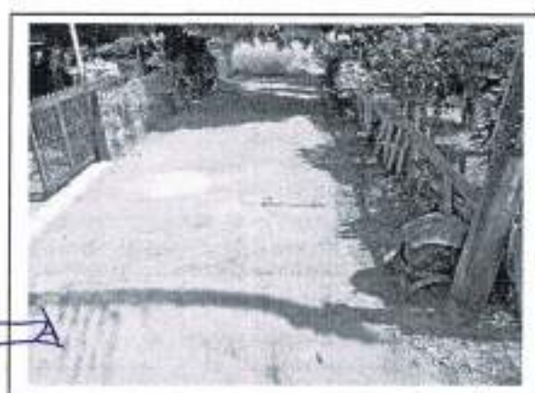
กม. ๐+๐๐๐๑ (สภาพสายทางโดยทั่วไป)
