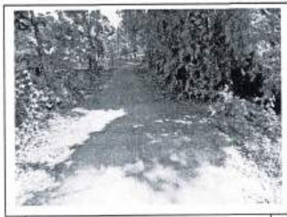
กม. ๐+๘๙๐ (สภาพสายทางโดยทั่วไป)
