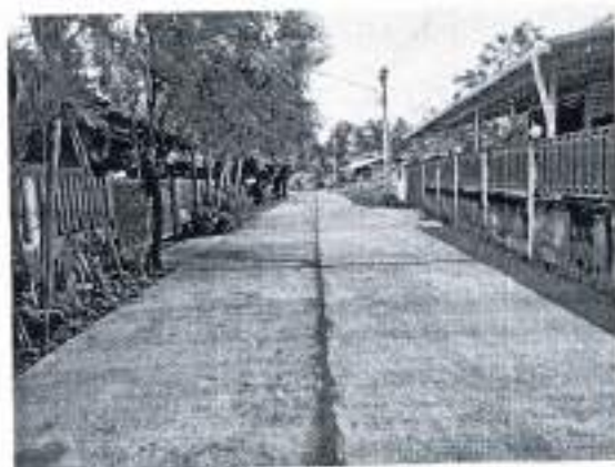
กม. ๐ + ๖๐๐ (สภาพสายทางโดยทั่วไป)
