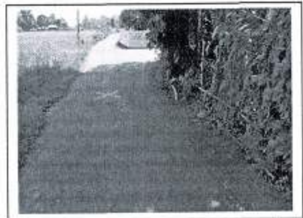
กม. ๑+๓๓๐ (สภาพสายทางโดยทั่วไป)
