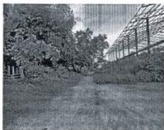
กม. ๐ + ๑๖๕ (สภาพสายทางโดยทั่วไป)
