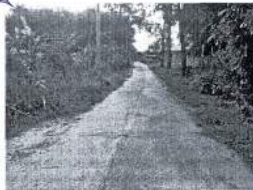
กม. ๐+๒๑๐ (สภาพสายทางโดยทั่วไป)
