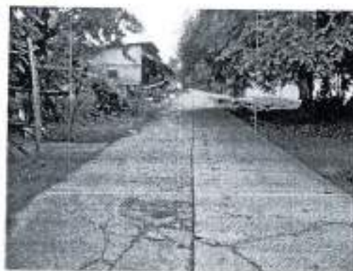
กม. ๐ + ๓๘๐ (สภาพสายทางโดยทั่วไป)
