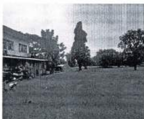
กม. ๐ + ๓๐๐ (สภาพสายทางโดยทั่วไป)
