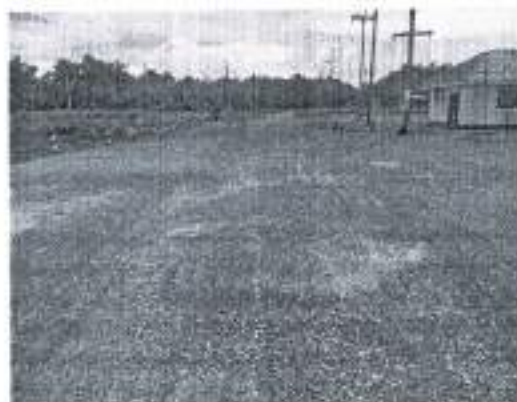
กม. ๐+๑,๑๔๐ (สภาพสายทางโดยทั่วไป)
