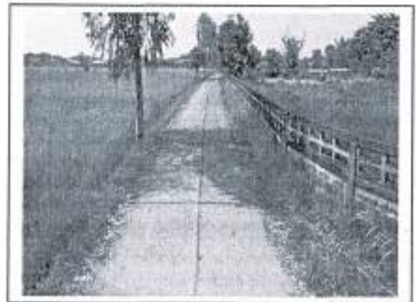
กม. ๐+๒๖๐ (สภาพสายทางโดยทั่วไป)
