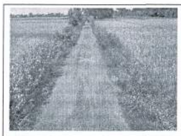
กม. ๐+๓๗๐ (สภาพสายทางโดยทั่วไป)
