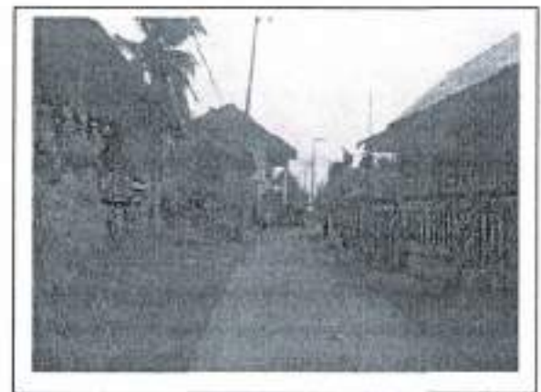
กม. ๐+๘๓๔ (สภาพสายทางโดยทั่วไป)
