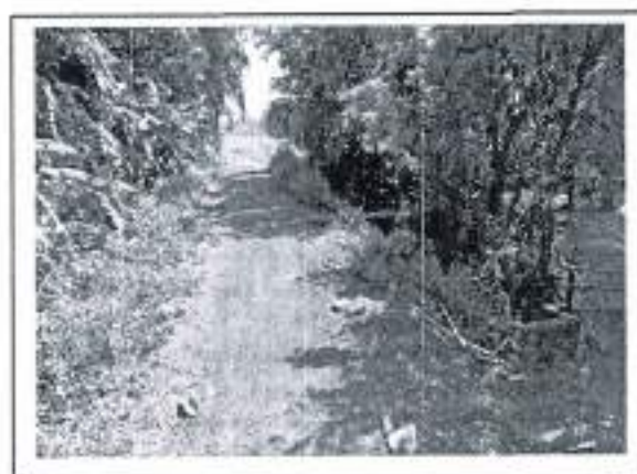
กม. ๐+๕๓๘ (สภาพสายทางโดยทั่วไป)
