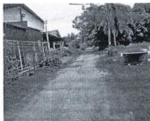
กม. ๐ + ๒๕๐ (สภาพสายทางโดยทั่วไป)
