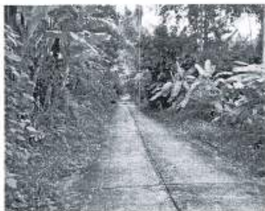
กม. ๐ + ๒๐๐ (สภาพสายทางโดยทั่วไป)
