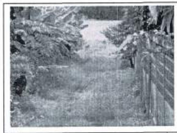
กม. ๐+๐๕๕ (สภาพสายทางโดยทั่วไป)
