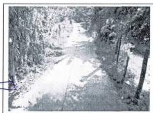
กม. ๐+๓๕๕ (สภาพสายทางโดยทั่วไป)
