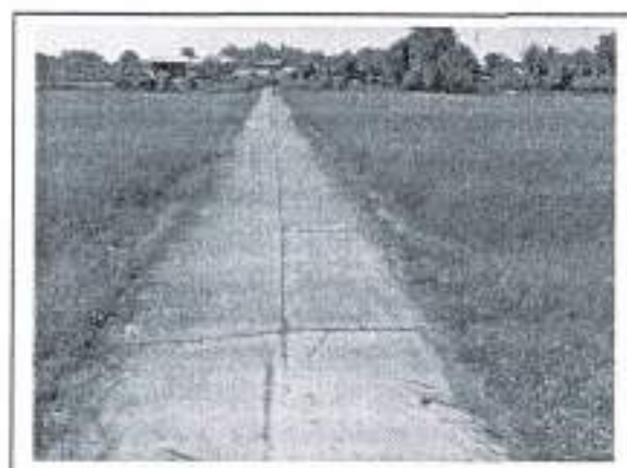
กม. ๐+๒๒๐ (สภาพสายทางโดยทั่วไป)
