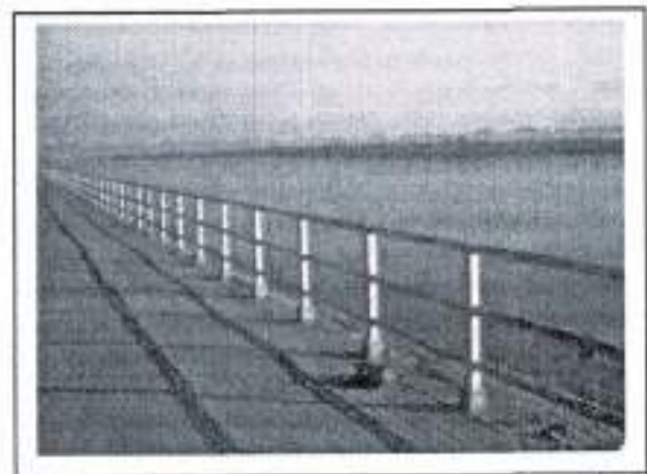
กม. ๒+๒๘๑ (สภาพสายทางโดยทั่วไป)
