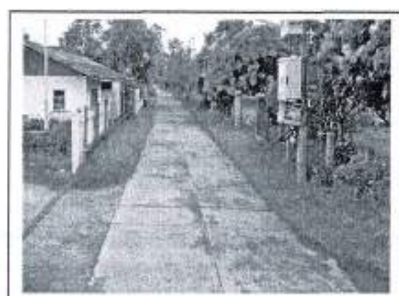
กม. ๓+๓๕๐ (สภาพสายทางโดยทั่วไป)
