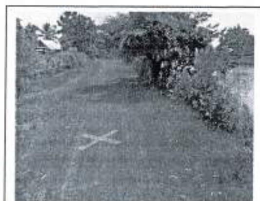
กม. ๓+๓๕๐ (สภาพสายทางโดยทั่วไป)
