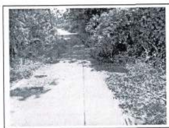
กม. ๐+๘๕๐ (สภาพสายทางโดยทั่วไป)
